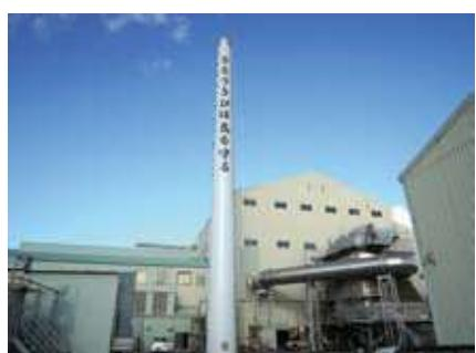
と加工されるまで、外部からの電気・燃料をほとんど使わずにサトウキビ 자체の纖維分を十分に活用し、製品を作り上げています。また、当社のボイラードは、約30年前から電気集塵機が併設されています。静電気の力で非常に細かい煤塵を取り除いているので、煙突から出てくる煙には煤塵がほとんど含まれておらず、当時から環境に配慮した操業を第一に考えております。次回は、サトウキビを搾つたジュースから不純物を取り除き、煮詰める工程、「清浄」を紹介します。
